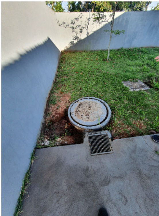
Imagem 4 – Fotos das fossas. Promover o aterramento da fossa e tampá-las adequadamente.
