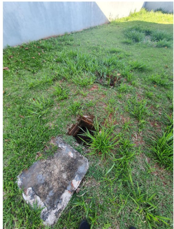
Imagem 4 – Fotos das fossas. Promover o aterramento da fossa e tampá-las adequadamente.
