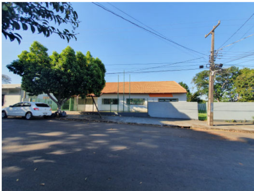
Imagem 2 – Foto da Fachada do Imóvel. Não há placa de identificação da Biblioteca Cidadã.
